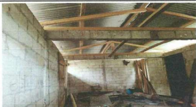
Foto 3: Se sustituirá láminas por láminas troqueladas y estructura metálica.
