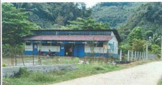
Foto 8: Se sustituirá la lámina de la escuela por lámina troquelada.
