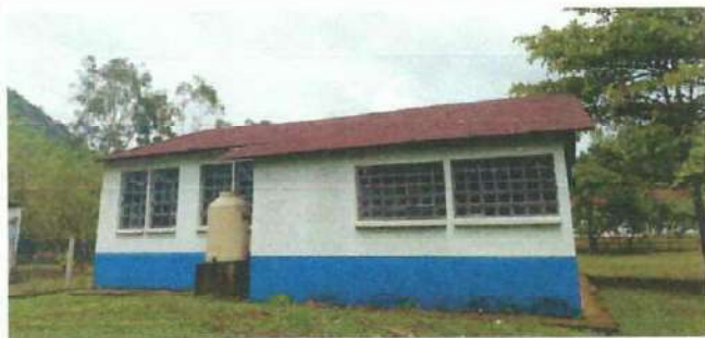
Foto7: Se sustituirá las láminas de la escuela por la lámina troquelada.
