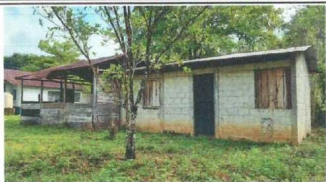
Foto1: Se adecuará este espacio para cocina.
