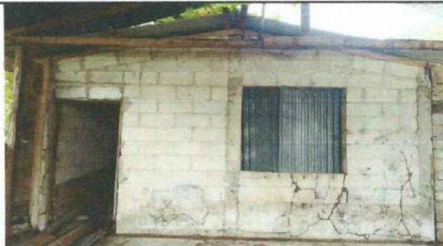
Foto2: Se levantará 3 hiladas block para lograr el nivel de la cocina.
