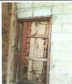
Foto 5: Se sustituirá la puerta de madera por puerta de metal.
