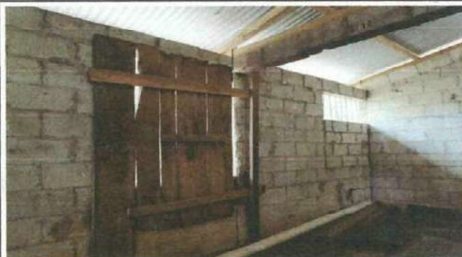
Foto 4: Se colocarán balcones en las ventanas y se pintarán las paredes.
